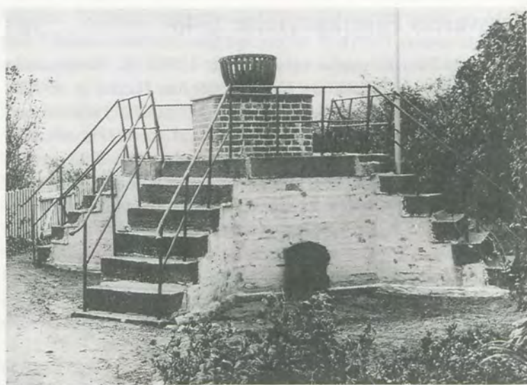
Kulfyr ved Halskov, opført 1727 og endnu i 1904 benyttet til vejledning for færgerne i usigtbart vejr. De ældste fyr var åbne blus i jernkurve, der enten var ophængt i vippegalger (vippefyr) eller faststående (som på billedet). Det afbildede kulfyr vedligeholdes stadig af Farvandsvæsenet (ældre foto, Farvandsvæsenet).
